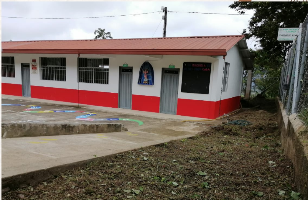
Fotografía 3: “Entrada” - CER La Amalia, Municipio de Venecia -Antioquia. Fuente: Elaboración propia (2021).
