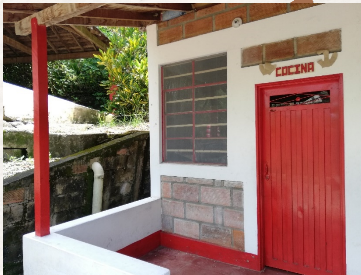
Fotografía 2: “Cocina” - CER Nueva Santa Rosita, Municipio de Venecia -Antioquia. Fuente: Elaboración propia (2020).
